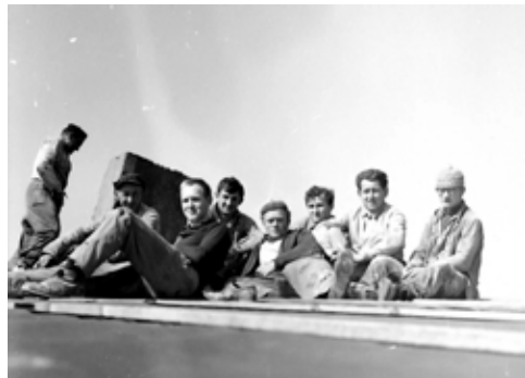
parta dělníků Pozemních staveb na střeše korkařské bytovky
