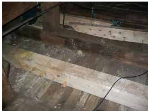
Foto prací na opravě stropních trámů kostela
