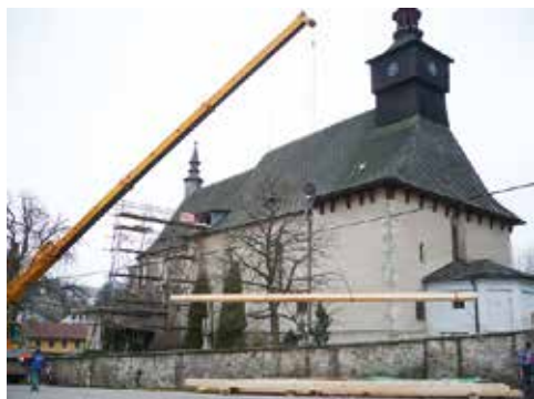
Foto prací na opravě stropních trámů kostela
