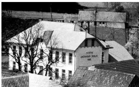
Na budově byl nápis STÁTNÍ OBČANSKÁ ŠKOLA 1923.
